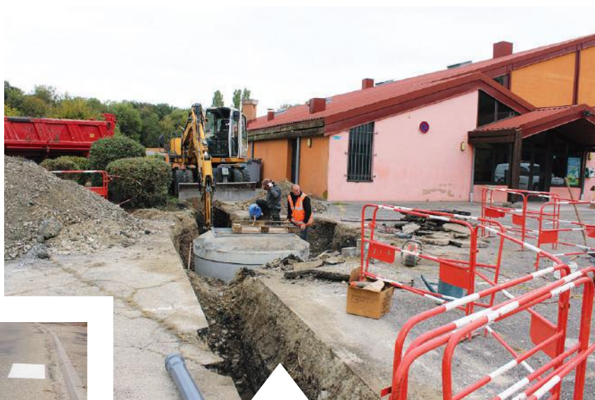
Mise aux normes du réseau d'assainissement
