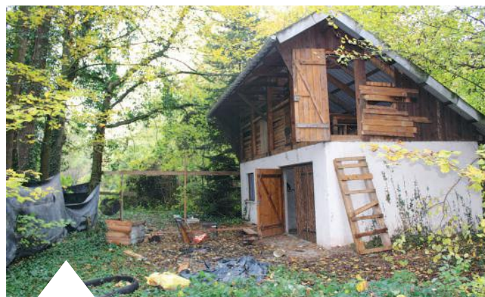
Démolition de l'abri forestier
